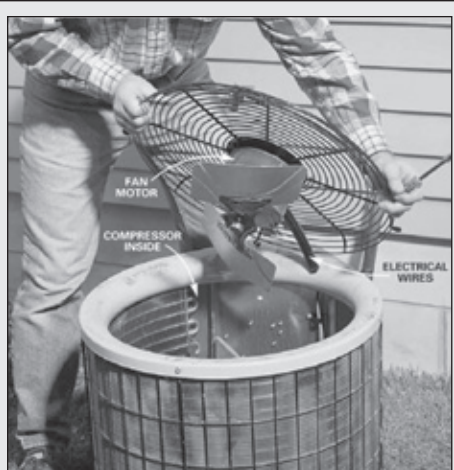
Photo 3 - Remove the grille.
